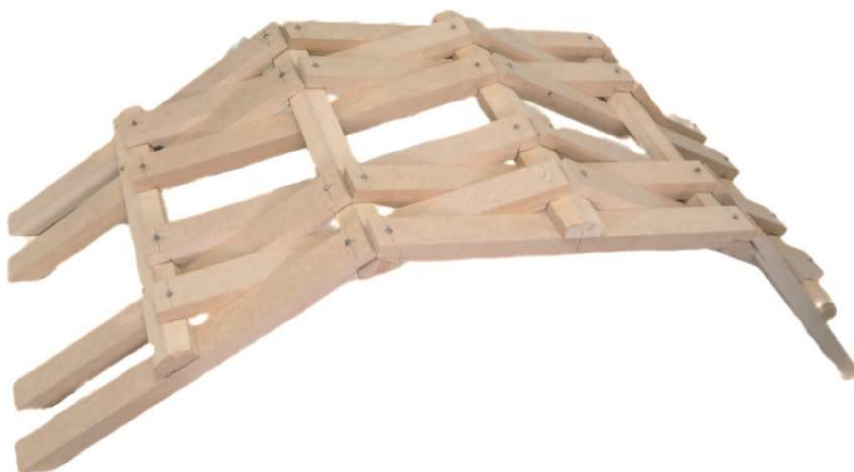
Figura 4 – Ponte autoportante em escala montada
